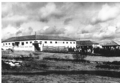
Berçário de Caruaru - obra social idealizada pelo Pe. Zacarias Tavares.
