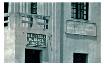
Detalhe da fachada da sede da ACC abrigando os serviços do Sesc Caruaru
